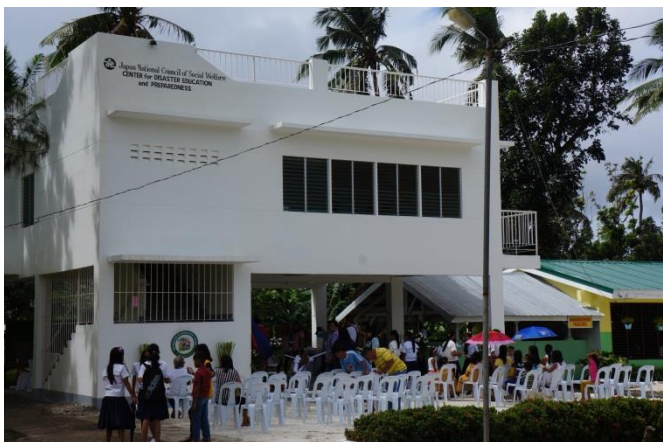
<サレジオ会が建設したセンターの外観>
